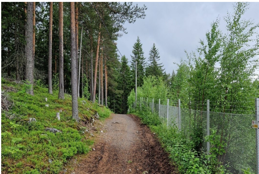
Figur 6. Rödbergets elljusspår som angränsar till ställverket.
