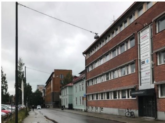
Figur 33. Magasinsgatan väster om kv. Skruven. Foto: Tyréns AB (2019).
