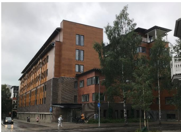
Figur 23. Byggnader inom fastigheten Embla 5, direkt sydväst om kvarteret Skruven. Källa: Tyréns AB 2019.
