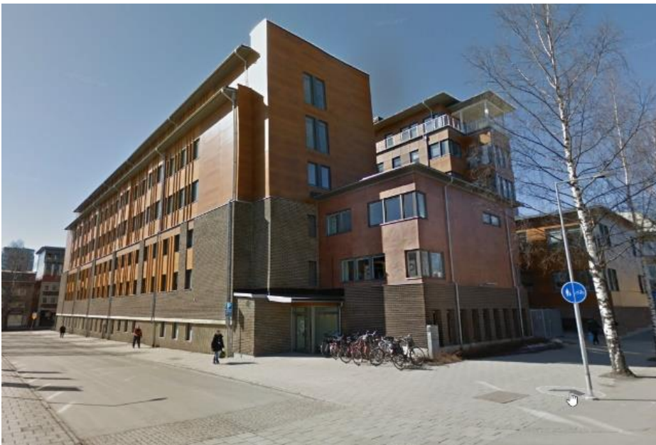
Figur 19 Försäkringskassans kontor på Embla 5 ligger i korsningen Nygatan-Magasinsgatan och uppfördes 1975. Byggnaden är utpekad i Byggnadsordningen för Centrumfyrkanten.
