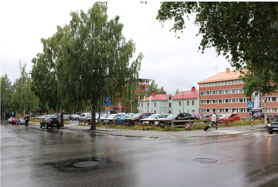
Figur 5 Planområdet sett från korsningen Västra Norrlandsgatan – Götgatan. I och med det obebyggda kvarteret är Dyckerten 2 väl synlig inom och omkring kvarteret Skruven. Bebyggelsen omkring kvarteret Skruven består i nuläget av byggnader uppförda i 3–4 våningar, vissa med inredd vindsvåning.
