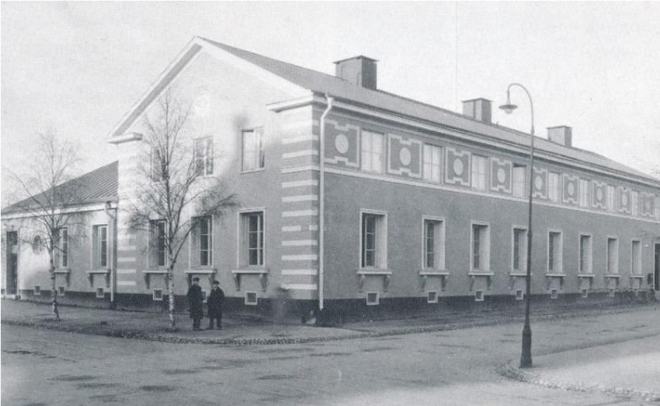
Figur 17 Gamla Posthuset år 1930. Byggnaden har kraftigt byggts om sedan dess. Källa Västerbottens museum.
