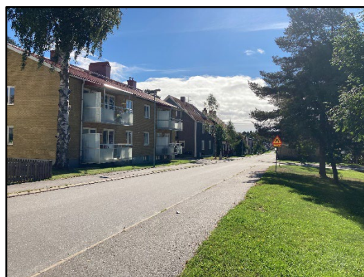
Figur 8. Södra Gimonäsvägen. Vy mot söder.
