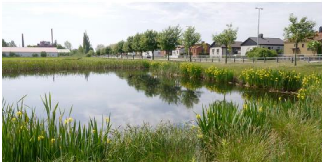
Figur 22. Ett exempel på en dagvattendamm i nordvästra Skåne. Bildkälla: NSVA:s hemsida.
