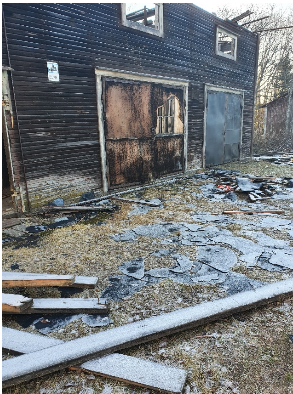
Figur 2. Tjärpapp och plank utspritt på marken intill provpunkt 21sc02.
