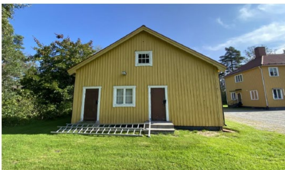
Figur 22. Garagebyggnaden på Hörneå 8:4.
