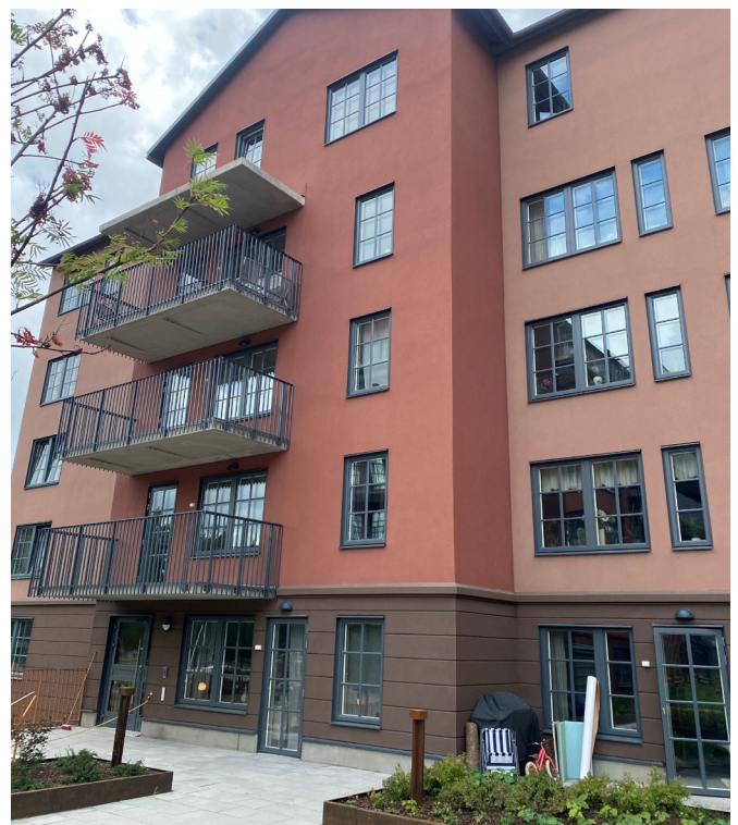
Utkragande balkonger som inte upptar för stor del av fasaden, Umeå kommun Teg.
