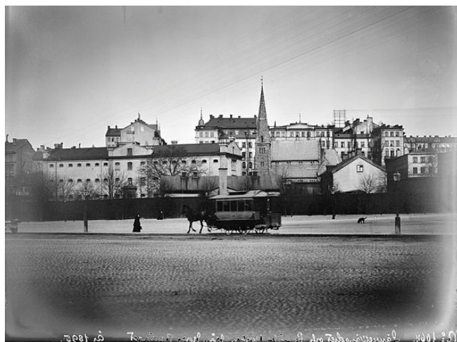
Det gamla läns- och straffängelset på Norrmalm i Stockholm 1895. Foto: fotograf okänd/Stockholms källan.
