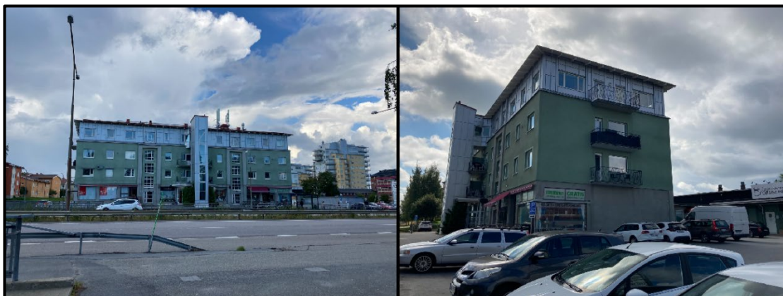
Figur 12. Byggnad mot Tegsesplanaden på fastigheten Bilen 2. Till vänster: vy från öst. Till höger: Vy från norr
