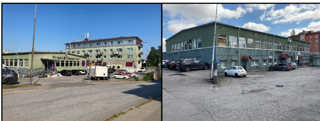
Figur 13. Verksamhetsbyggnad på fastigheten Bilen 2. Till vänster: Vy från sydväst. Till höger: Vy från nordväst.
