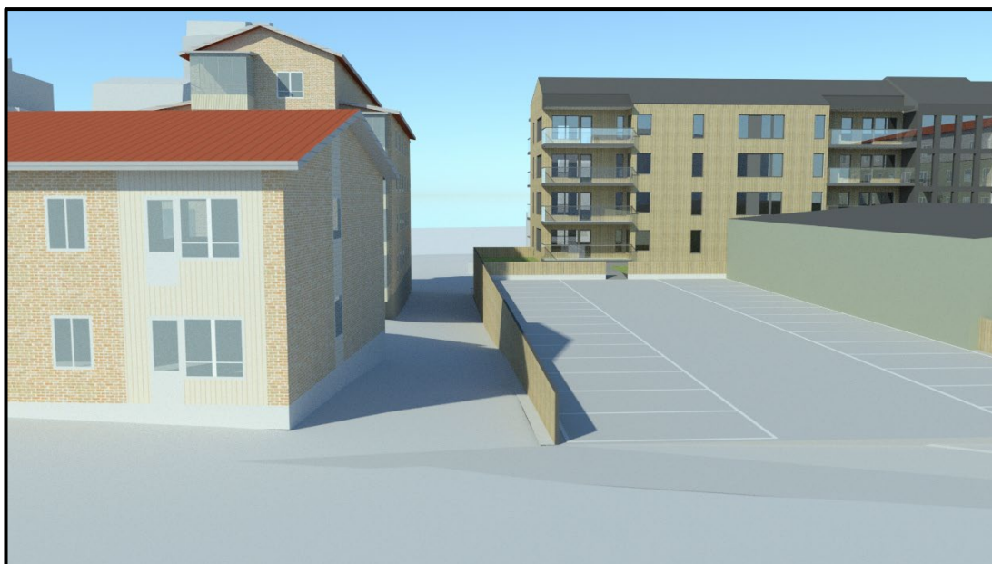
Figur 17. Exempel på utformning av parkeringsanläggningens övre däck. Bilden visar befintliga markhöjder på Bilen 1 och Nybrogatan och högsta tillåtna höjd på parkeringsanläggningen. I skissen har ett staket placerats i fastighetsgräns mot fastigheten Bilen 1.
